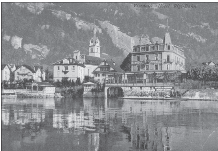
Hotel nach dem Umbau um 1900.
