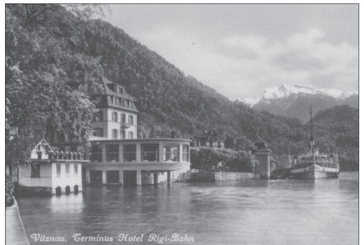
Anbau im Bauhausstil des Architekten Arnold Berger von 1931 (ohne Steg von 1984).
